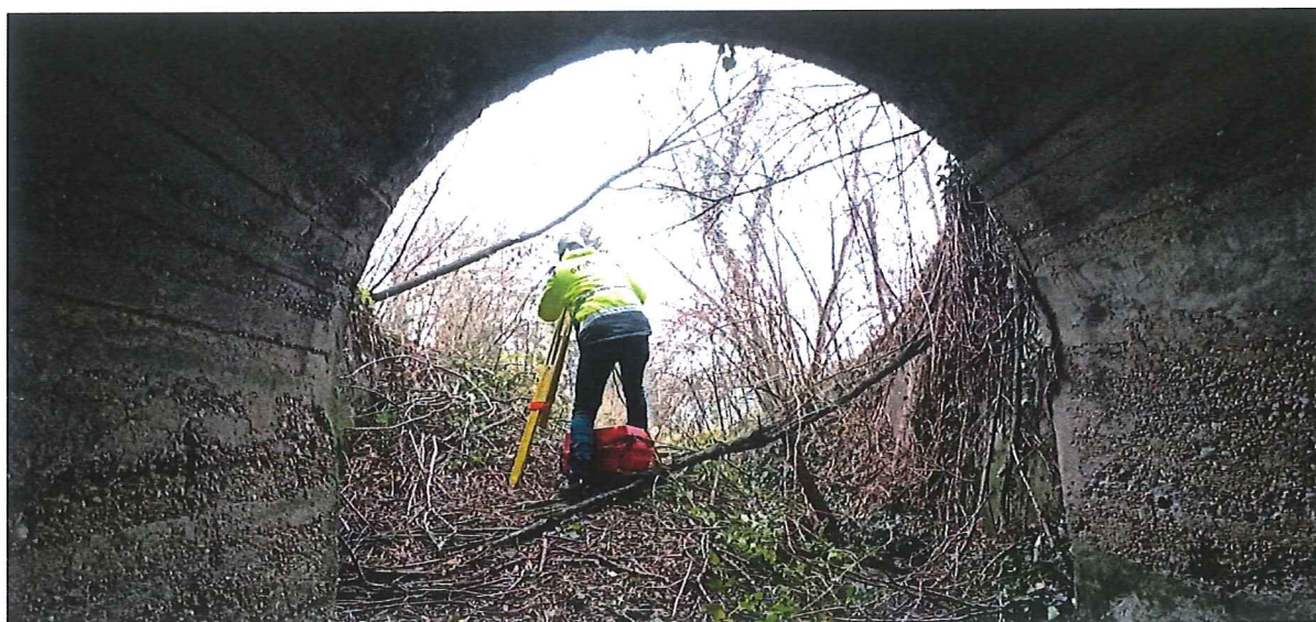
Geodetické zameranie skutkového stavu priepustu
